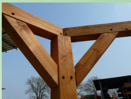
gezapfte Verbindungen werden mit Holznägeln aus Lärche verbunden
