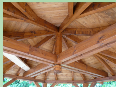
Blick von unten auf die Dachkonstruktion, fertig mit Dachschalung montiert
