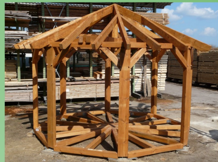
Bausatz fertig montiert incl. Unterkonstruktion für Fußboden (optional), es fehlt noch die Dachschalung
